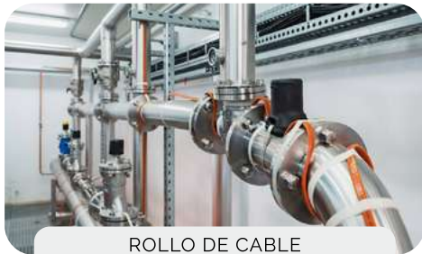
ROLLO DE CABLE CALEFACTOR DESCONGELANTE
